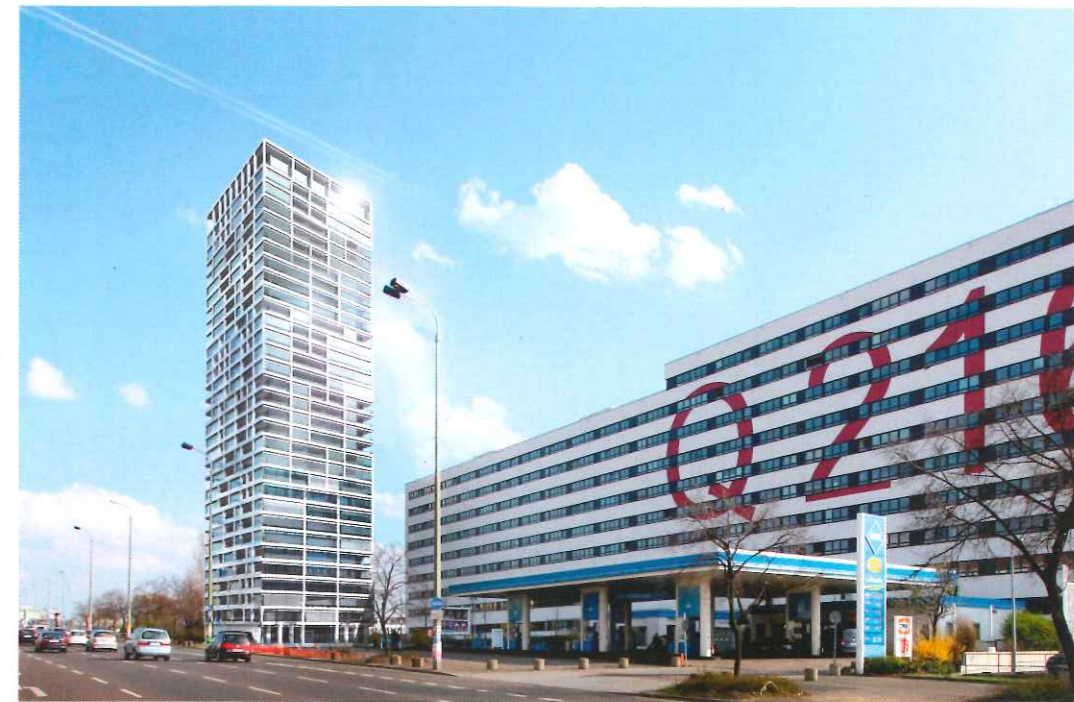
Von der Platte in die Höhe: Entwurf für günstige Wohnungen in Berlin-Lichtenberg
